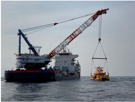
写真-3 起重機船によるブイ設置状況
