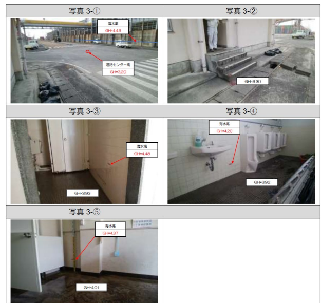
写真-3 2020 年 9 号台風 (T2009) の被害状況
