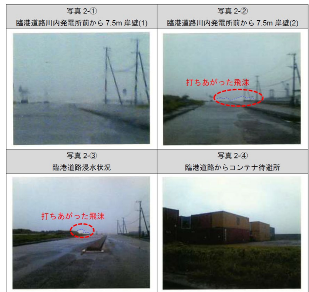
写真-2 2006 年 13 号台風 (T0613) の被害状況
