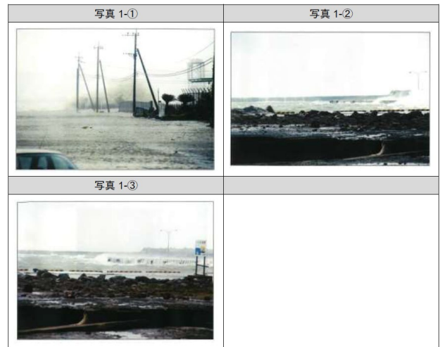
写真-1 2004 年 18 号台風 (T0418) の被害状況
