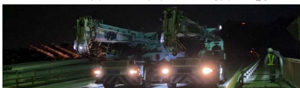
図-6 ラフタークレーン並走状況（海側走行）
