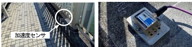
図-5 加速度センサの設置状況（海側の地覆上）
