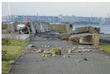
図1 後退パラペットの倒壊（本牧D突堤）
