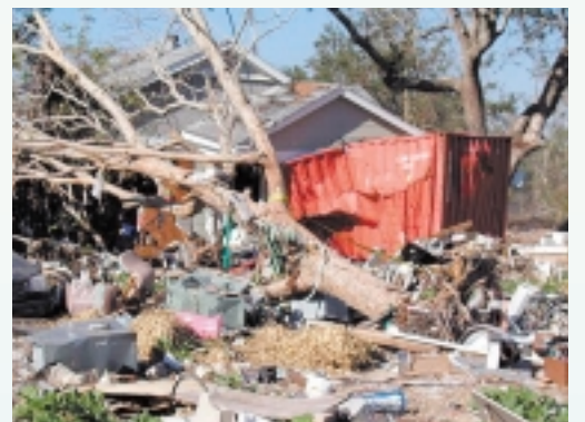
カトリーナ現地調査より
