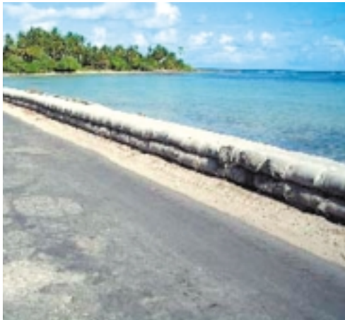
写真3 護岸の高上げ
