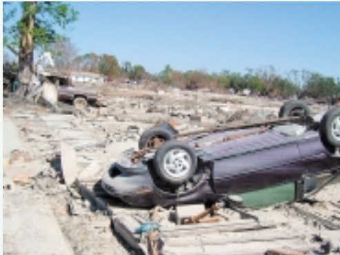
カトリーナ現地調査より
