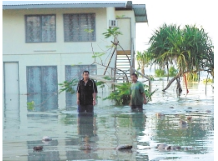
写真1 洪水・冠水被害
