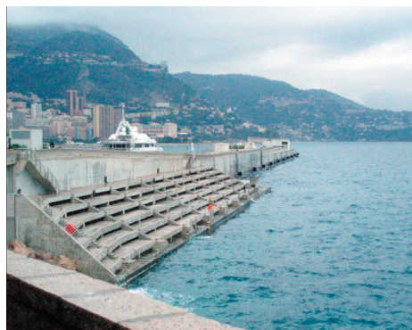
写真-6 浮体係船岸 (側面)
