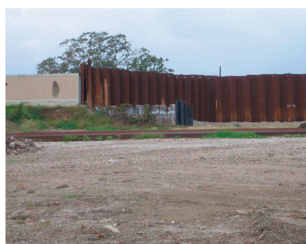
写真－１ 暫定的な防潮堤
