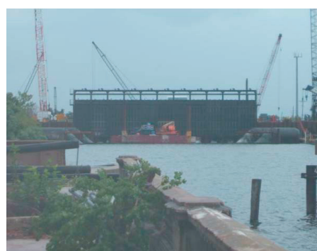
写真－２ 水門の設置工事の状況
