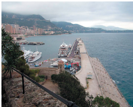
写真-5 浮体係船岸 (上面)
