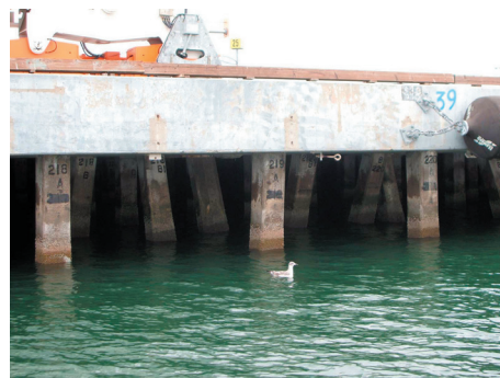
写真-13 コンテナ埠頭の柱（四角）
