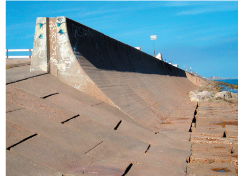
写真-8 シーウォール (Seawall)
