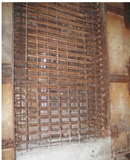
写真4 剛継手部の施工
