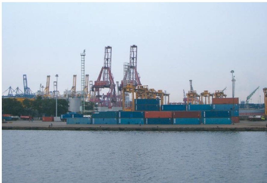
写真3 コンテナバース
