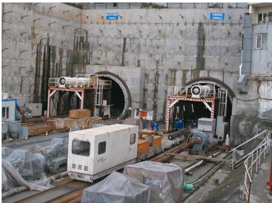
写真3 坑口部 (アジア側) 工事現場
