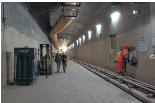
写真5 沈埋函の内部
