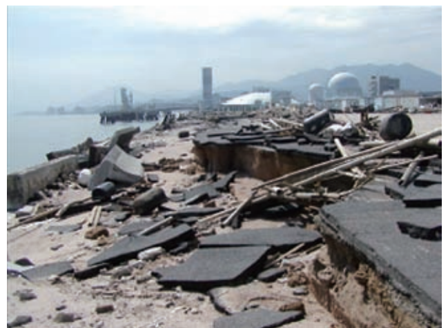
図4 台風0418による広島港の護岸被災
