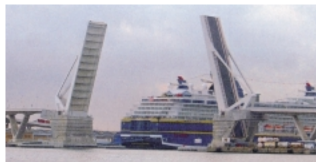
写真-5 新バルセロナ港橋
