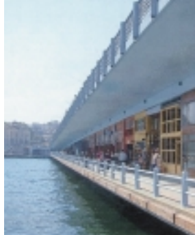
写真-4 新ガラタ橋のアプローチ部
