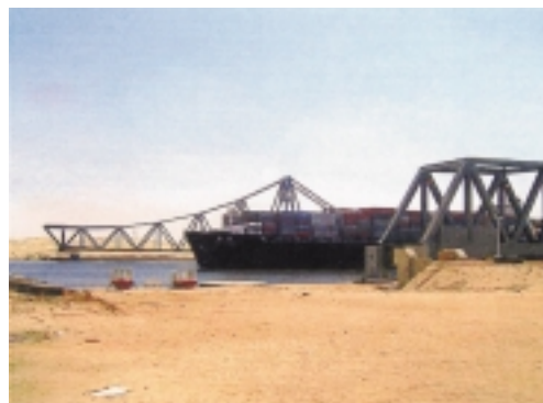
写真-1 エルフェルダン橋（船舶航行状況）
