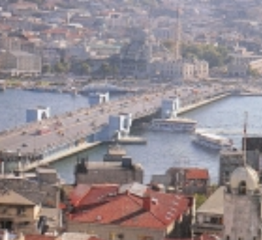
写真-3 新ガラタ橋
