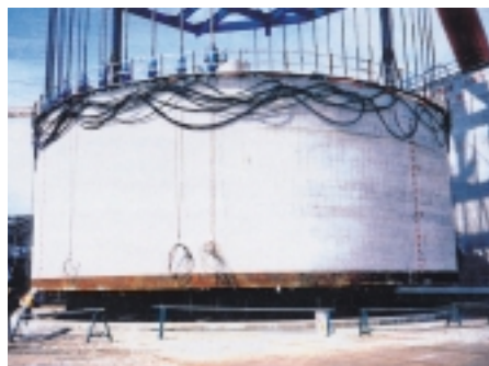
写真-2 直江津港作業基地防波堤基礎部
