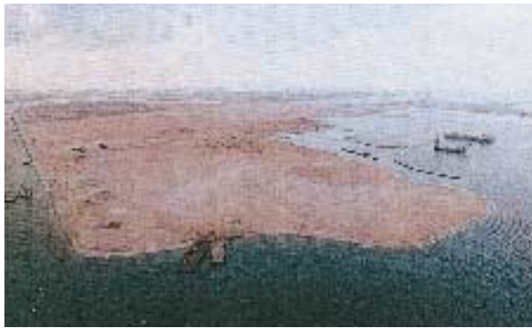
ジュロン島3期(3B)埋立工事
