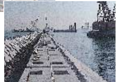
護岸築造の作業状況（2点）
