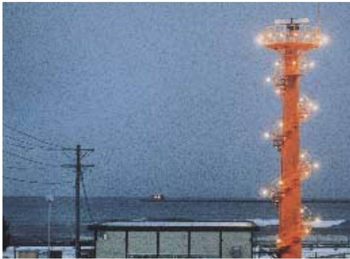
波力発電により点灯するタワーに設置された照明
