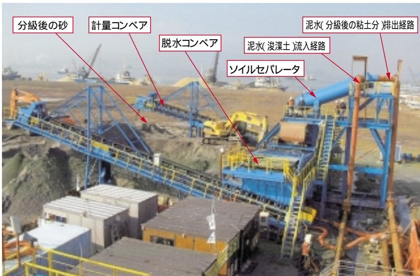
写真-1 分級工事の写真
