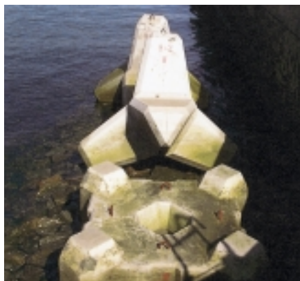
写真—1 鉄鋼スラグ水和固化体
