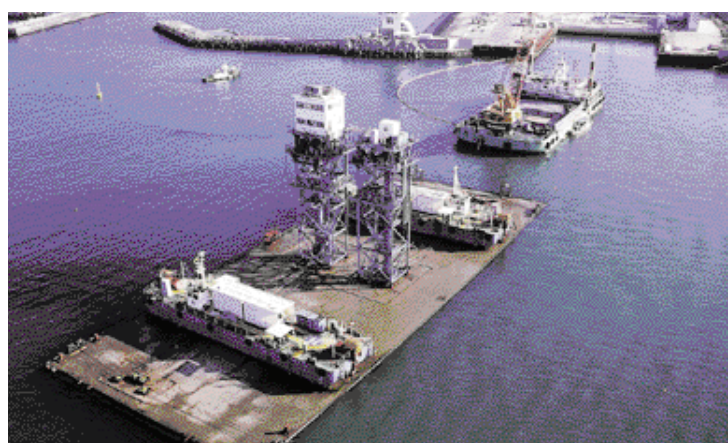
写真—2 沈設直前の状況（写真は3号函）
