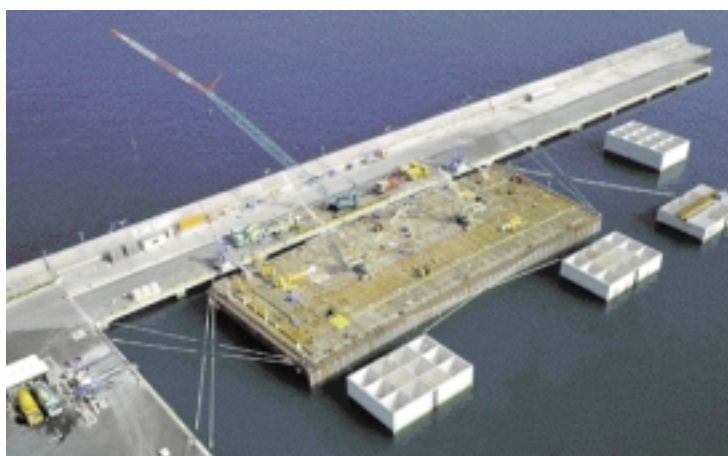
写真—1 コンクリート海上打設の様子
