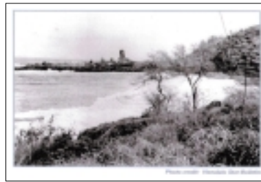
写真 - 4 チリ津波の被害
