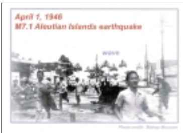
写真-2 アリューシャン津波の被害(1)
