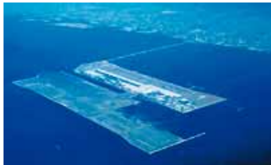
写真1 2期空港島造成状況（平成16年2月）
