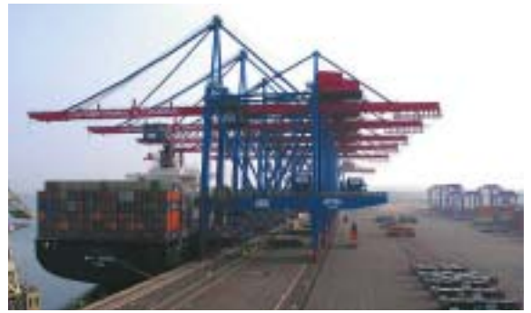
写真4 コンテナクレーン
