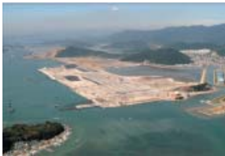
写真2 北側現地状況 (2004年11月)
