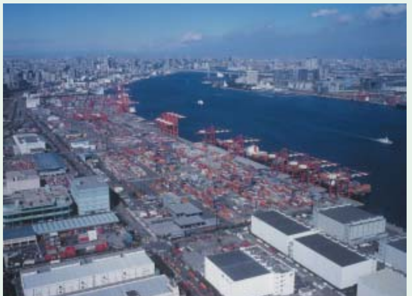
大井コンテナ埠頭（陸側より） ＜写真提供＞（財）東京港埠頭公社
