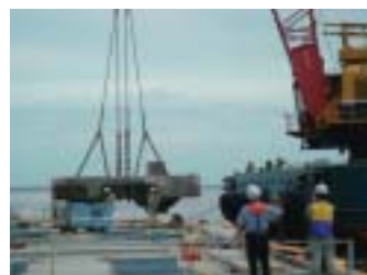
上部工改良状況写真
