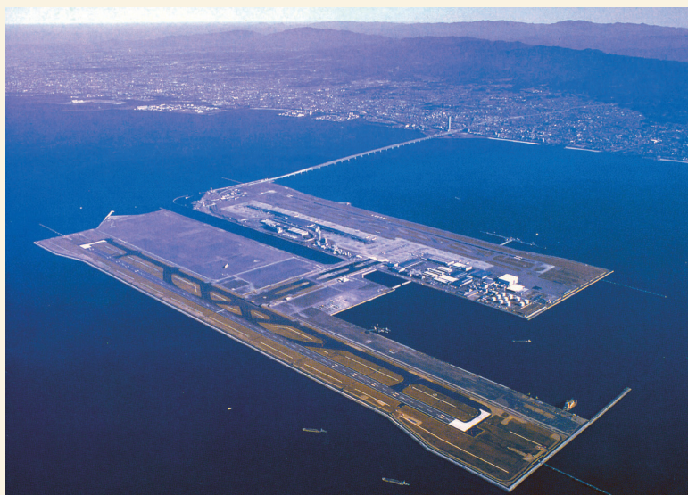
図-2 第2滑走路が暫定供用された関西国際空港 (出典: 「関西国際空港2期工事の概要」パンフレットより)
