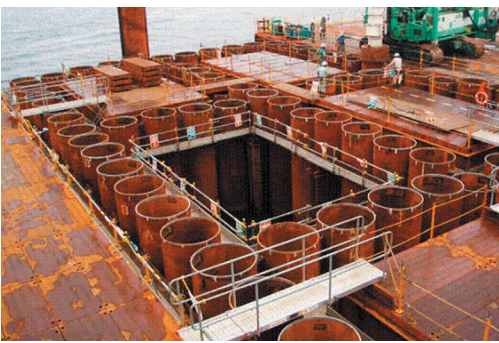
写真-1 施工中の鋼管井筒矢板
