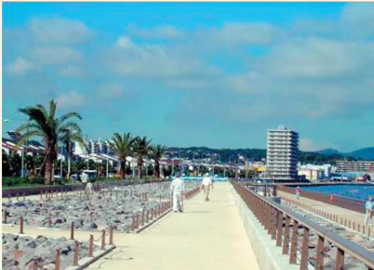
図-1 景観や環境に配慮した「安心と憩いを提供する」護岸の整備 (横須賀港馬堀海岸高潮対策事業) (写真提供: 国土交通省港湾局)
