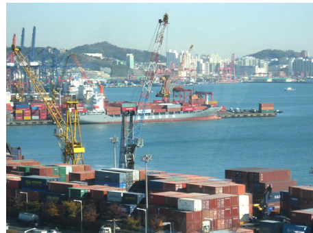
写真-3 釜山港北港中央埠頭周辺の状況
