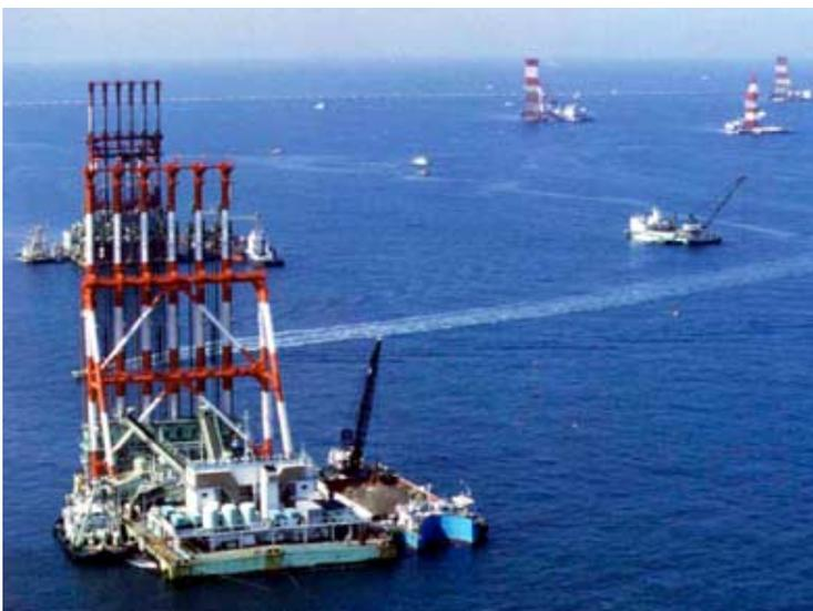
大型サンドドレーン船による地盤改良
