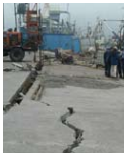
写真7 タルカワノ港 重力式岸壁の被災状況
