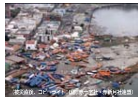
写真2 タルカワノ港の被害
