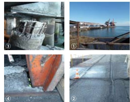
写真10 製鉄会社専用縦横橋の被害状況
