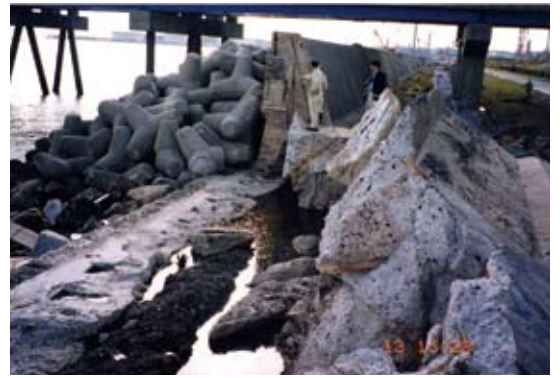
写真2 護岸の破壊
