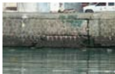
写真8 タルカワノ港 ブロック積護岸の被災状況
