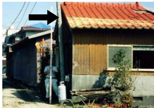
写真1 屋根まで浸水した家屋
