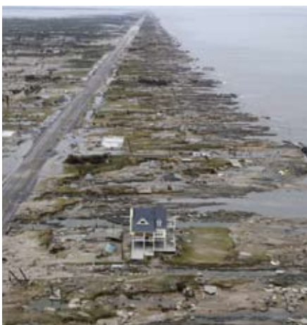
写真2 高潮災害から生き残った一軒の家
