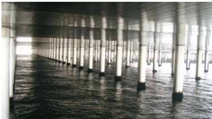
写真1 羽田D滑走路栈橋部外観
