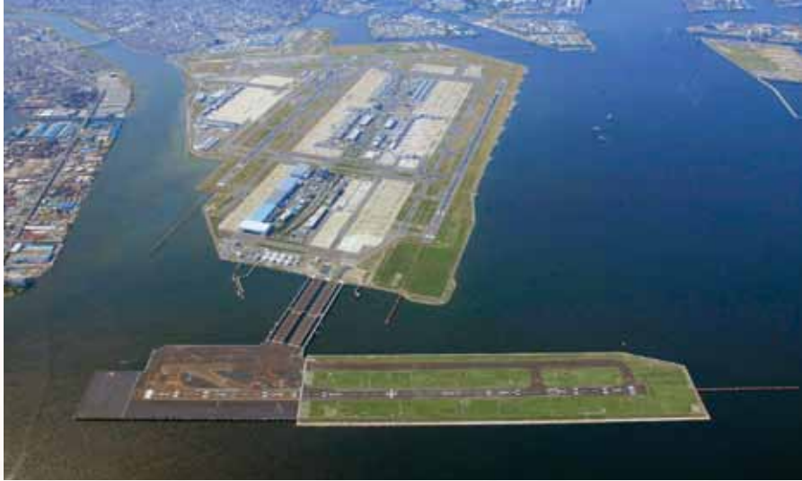
D滑走路 航空写真(2010年9月2日撮影) 写真提供：羽田再拡張D滑走路建設工事共同企業体
