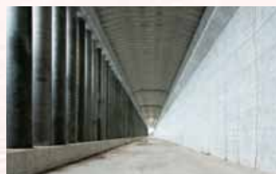
鋼管矢板井筒護岸(通水前)
