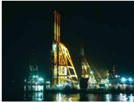
写真1 SD夜間施工状況
