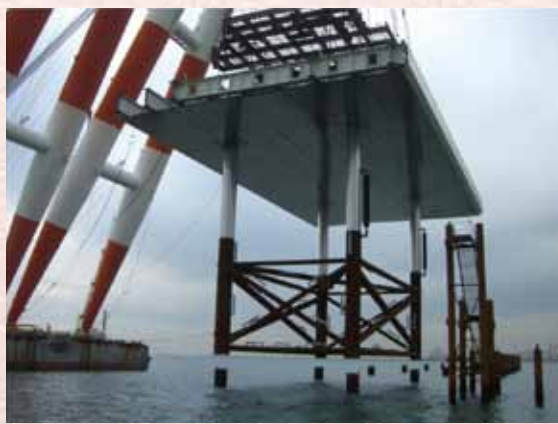
最初のジャケット据付
