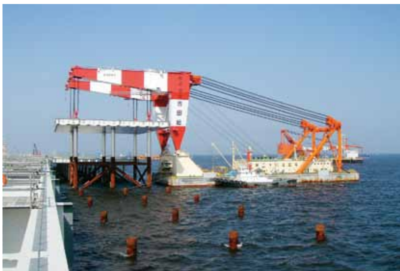
写真9 ジャケットを据えつける作業。 高さ制限があるため、低頭式起重機船を使用
