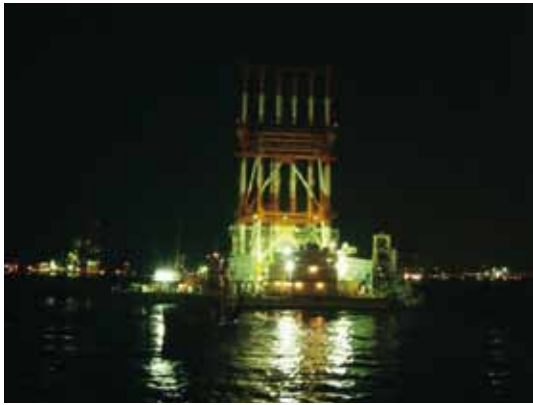
写真2 SCP夜間施工状況
