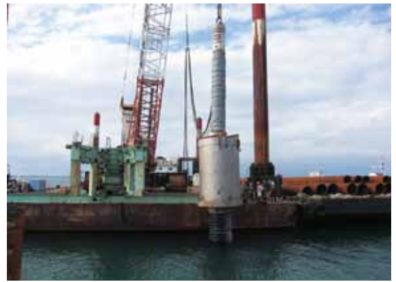
写真1 油圧ハンマ騒音低減装置を用いた鋼管杭打設
