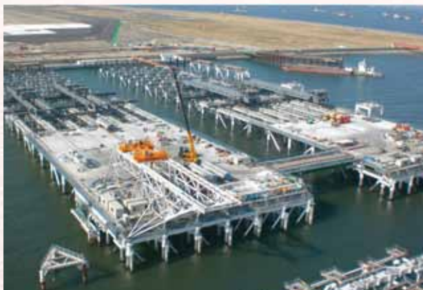
連絡誘導路の施工
