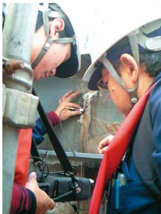
写真12 発注者側検査の様子
