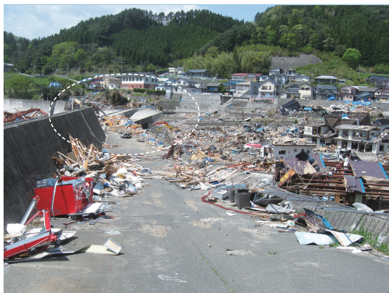
写真2 破壊された護岸 (中央部) と背後の被害 (唐丹小白浜)
