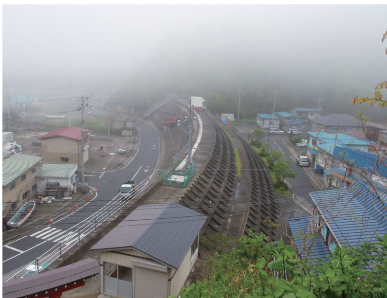
写真5 普代村太田名部地区防潮堤(右が守られた陸側)
