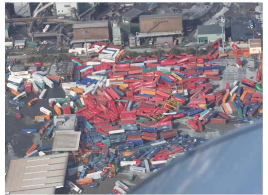
写真6 【仙台塩釜港(仙台区)】コンテナ散乱
