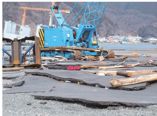
写真2 【釜石港】荷役機械とヤードの損壊
