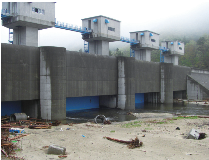
写真4 普代村の水門(海側)
