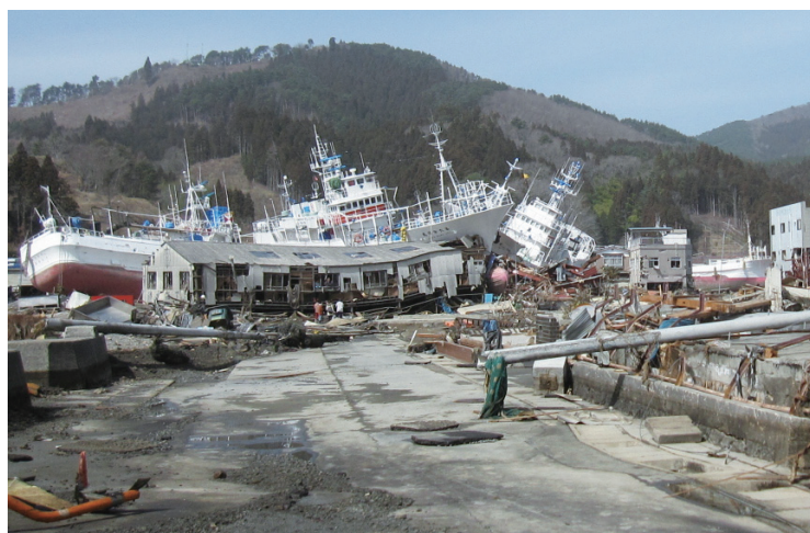
写真4 沿岸域での被害状況。船舶などの漂流物により被害の程度は拡大していった
