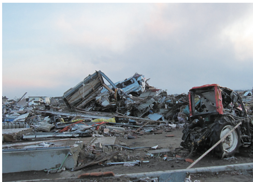
写真3 破壊的な被害を受けた状況（仙台市若林地区と荒浜地区）
