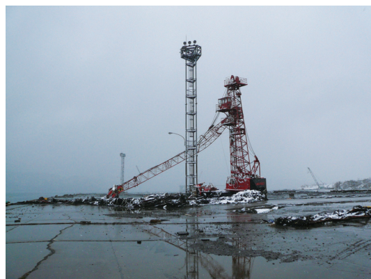
写真1 【宮古港】荷役機械の損壊とがれき
