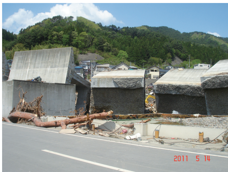
写真1 破壊された護岸 (ASCEとの調査：唐丹小白浜地区)
