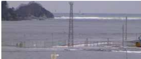
写真1 釜石湾口防波堤 津波作用時の越流状況 (東北地方整備局釜石港湾事務所撮影)
