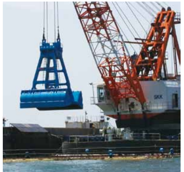
写真1 WGB浚渫工法
