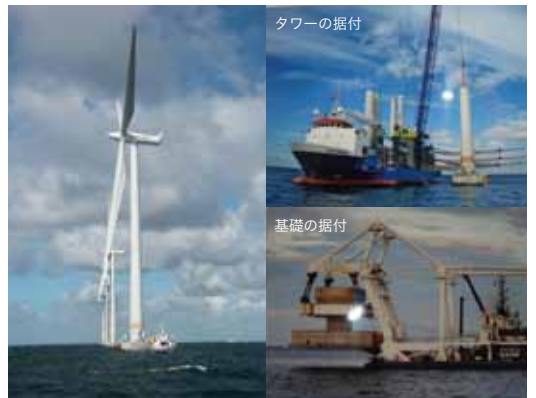
写真1 建設中のLillgrund洋上風力発電所(スウェーデン)
