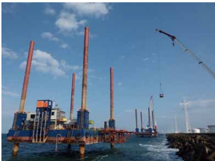
写真5 第2計画海上施工
