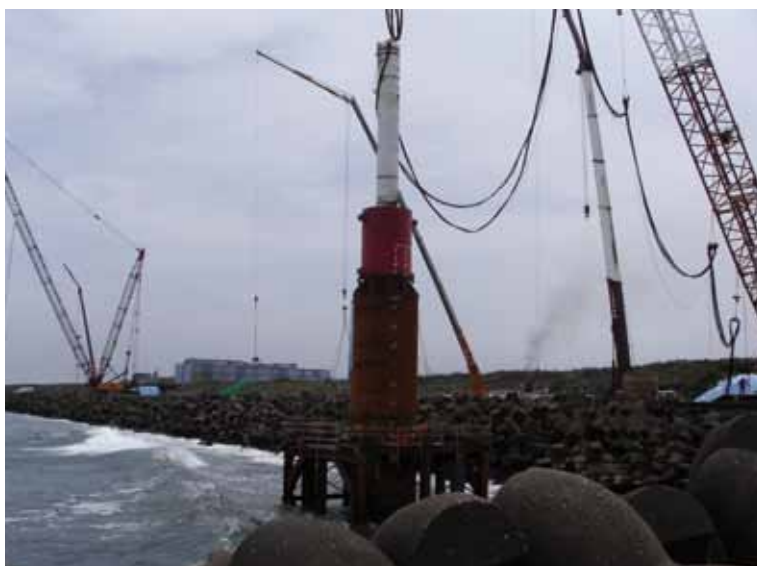
写真3 基礎モノパイル打設
