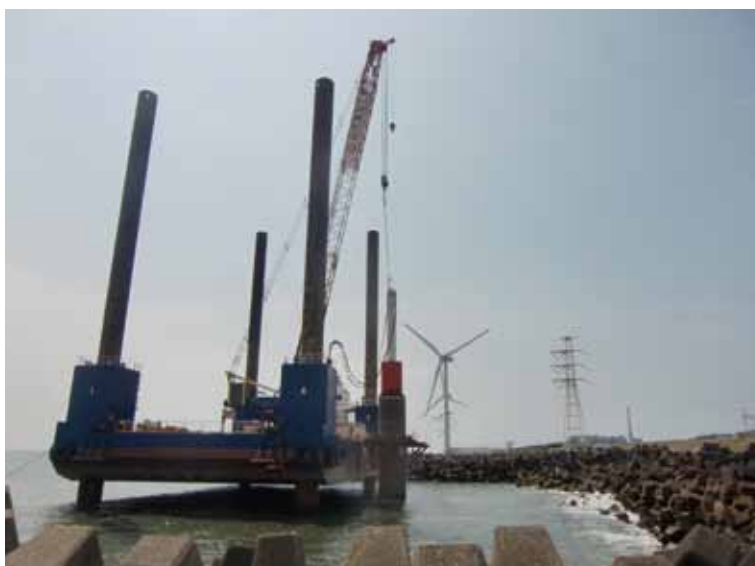
写真6 第2計画基礎モノパイル打設1
