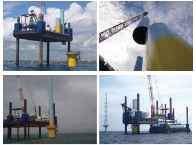
写真4 風車の組み立て
