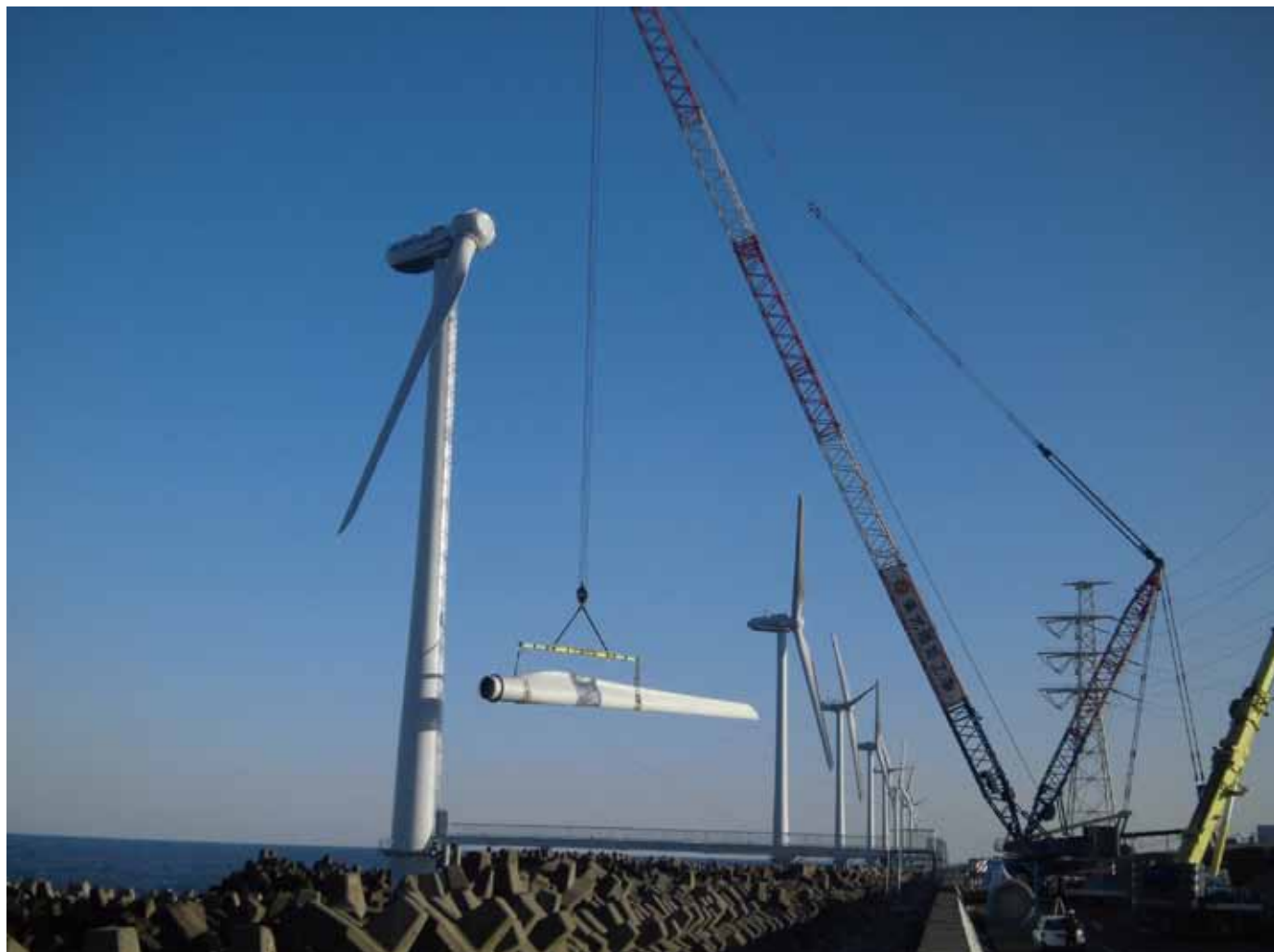
写真8 第2計画ブレード据付
