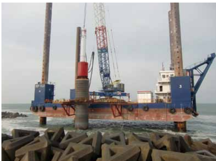
写真7 第2計画基礎モノパイル打設2
