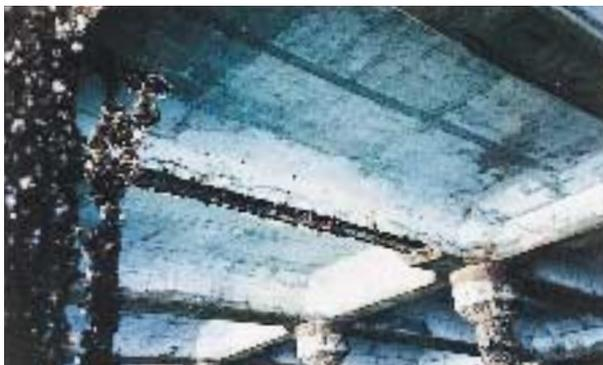
写真1 鉄筋腐食の著しい棧橋上部工の下面
