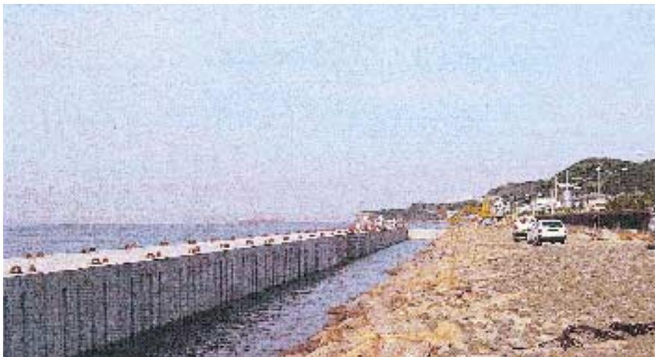
写真 3 直立消波ブロック据付施工状況写真(平成13年8月)
