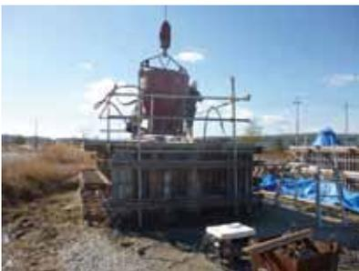
写真5 根固めブロックコンクリート打設状況
