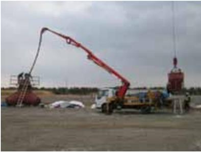
写真4 消波ブロックのコンクリート打設状況
