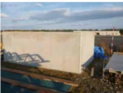
写真6 根固めブロックの製作後の出来形状
