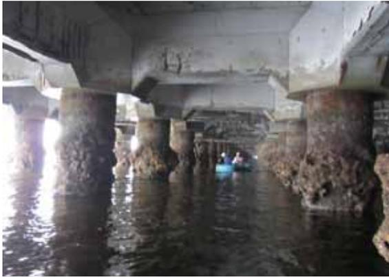
写真1 栈橋上部工の目視点検(船上から)
