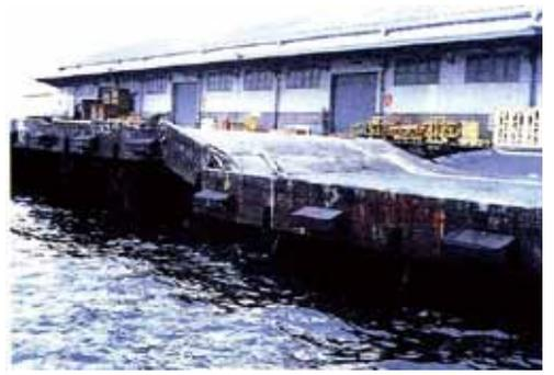
写真1 鋼管杭の折損による上部工の陥没
