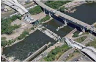
写真4 米国ミネソタ州で崩落した高速道路橋(出典:日経コンストラクション)
