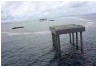
写真2 沖ノ島鳥島港湾施設 (国土交通省港湾局より)
