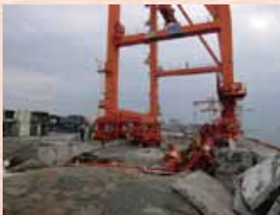
東日本大震災で被災した仙台港 コンテナ埠頭(2011年3月)
