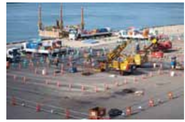
写真2 和歌山下津港岸壁の液状化対策
