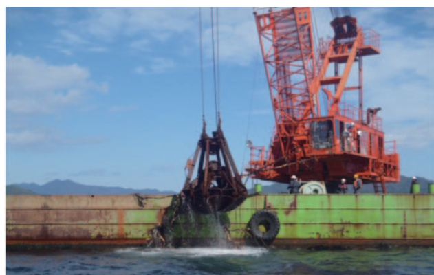
写真4 撤去作業状況
