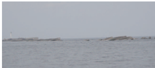
図2 相馬港沖防波堤の被災状況
