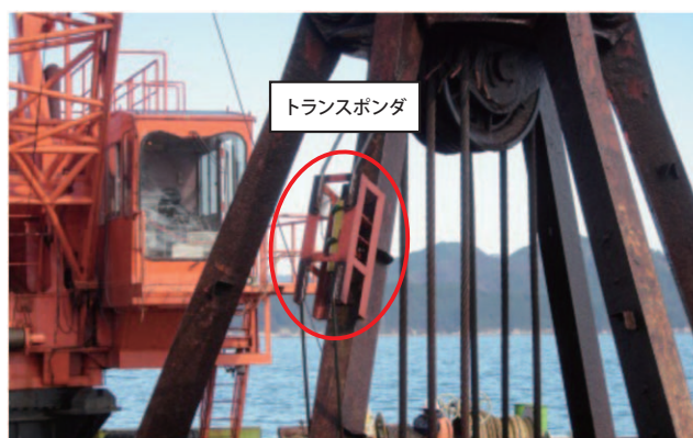
写真3 トランスポンダ設置状況
