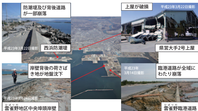
写真2 石巻港区の被災状況
