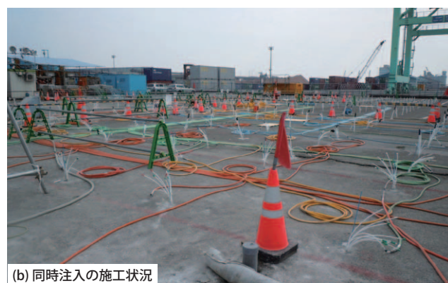
写真2 施工事例（八代港）
