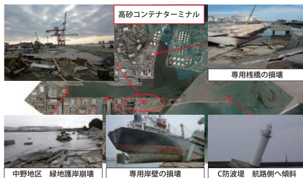
写真1 仙台港区の被災状況
