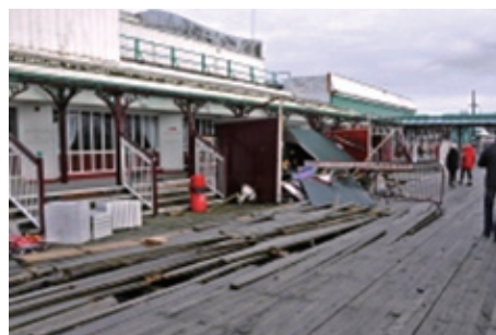
写真9 ブラックプール北栈橋を襲った高潮・高波被害(2013年12月)BBCニュース映像より
