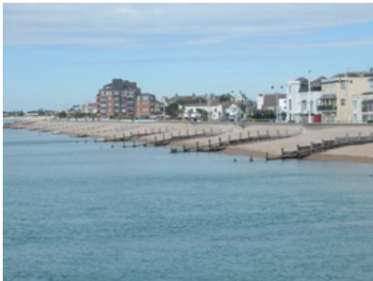
写真4 海浜安定化対策(ボグナ・レジス栈橋)
