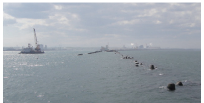
図-1 八戸港北防波堤の中央部の被災状況
