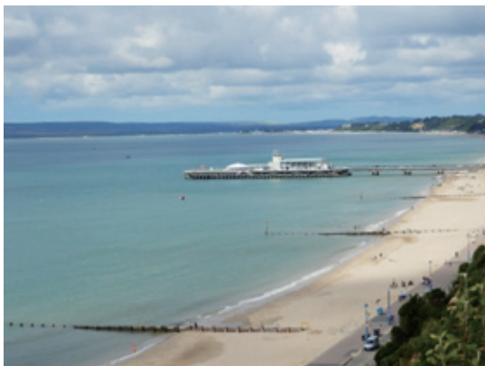
写真5 海浜安定化対策(ボーマス栈橋)
