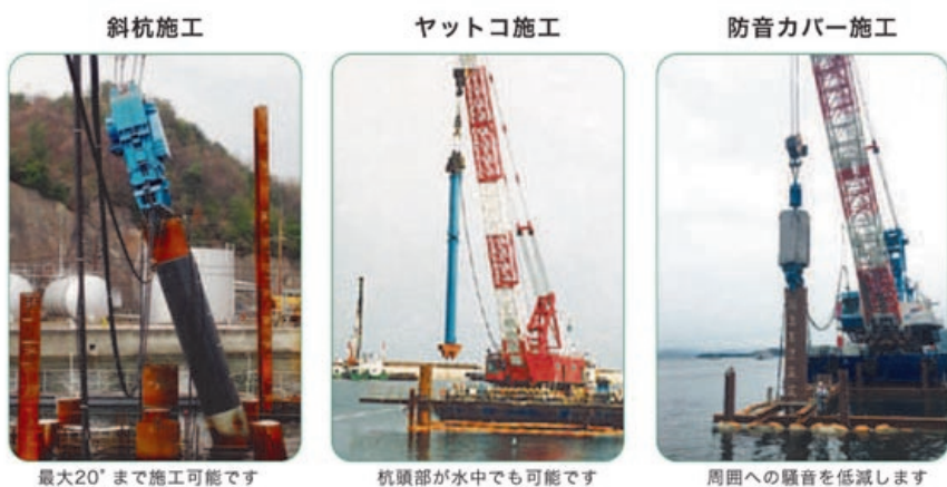
写真1 施工バリエーション
