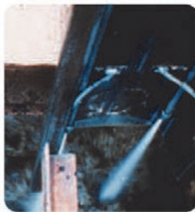
4MPa x 40ℓ/分程度の低圧&少量の水を使用します
