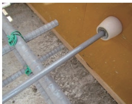
写真5 PVB樹脂被覆セパレーター
