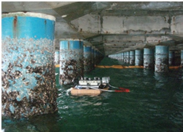
図2 ROVによる栈橋下面の点検診断状況
