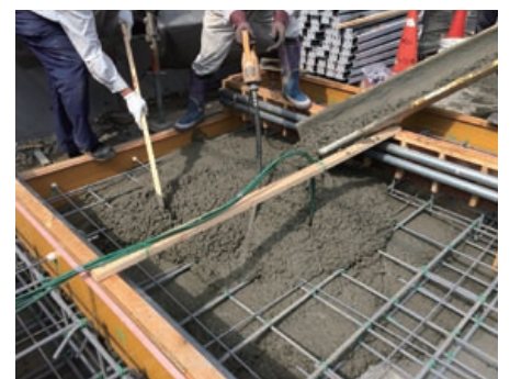
写真6 コンクリート打込み状況
