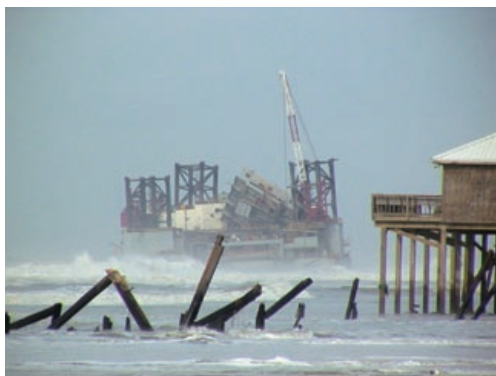
図1 ハリケーンカトリーナによる被害
