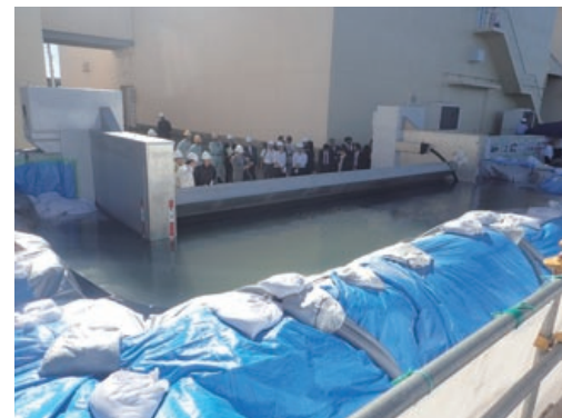
図3 フラップゲート式陸閘(徳島県撫養港海岸桑島瀬戸地区)
