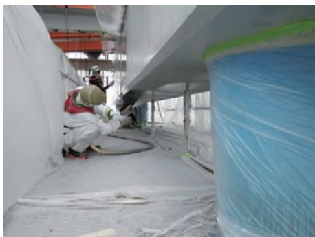
栈橋での施工状況
