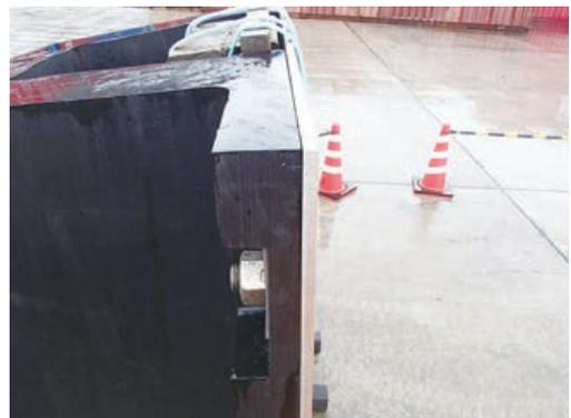
写真3 鋼板へのボルト止め状況
