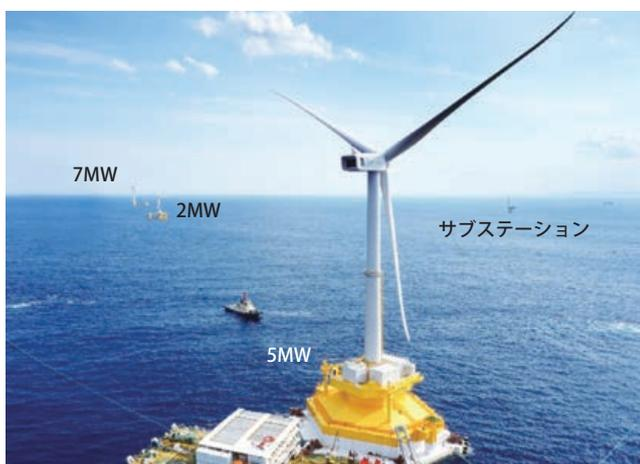
図5 福島沖世界初の浮体式洋上ウィンドファーム<sup>(7)</sup>
