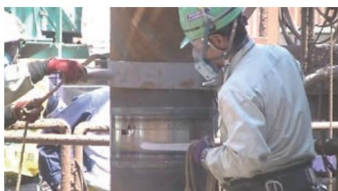
写真4.3 接合手順3(継手の回転)
