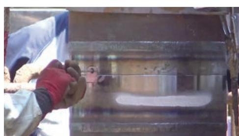
写真4.4 接合手順4(抑止キー位置を合せ、回転抑止キーを取付け接合完了)
