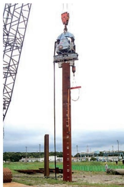
写真5 パイプロハンマでの施工試験状況
