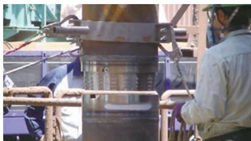
写真4.1 接合手順1(継手の位置合せ)
