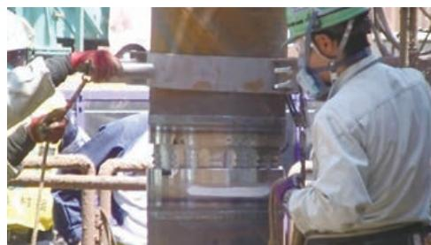
写真4.2 接合手順2(継手の挿入)
