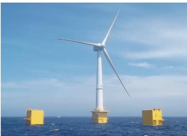
図3 世界最大級の7000kW洋上風車<sup>(7)</sup>
