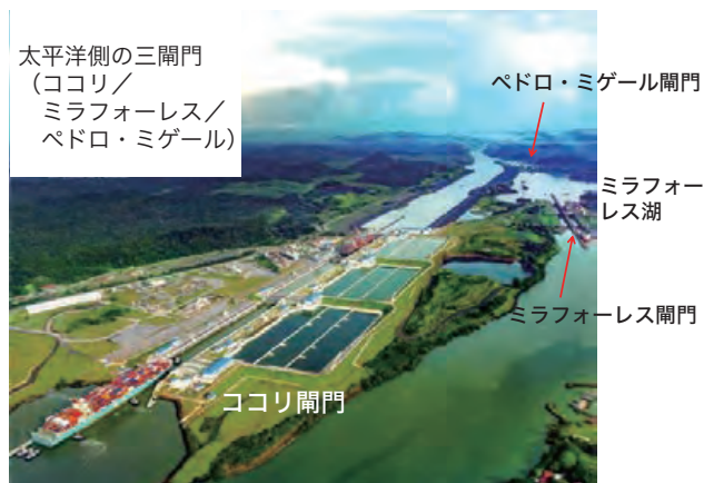
写真1 太平洋側の三閘門
