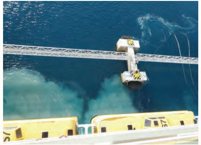
接岸の様子(ドルフィン、防舷材、係留索とスラスタによる砂の舞い上がり)
