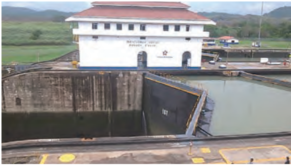
写真2(a) 観音開き式水門
