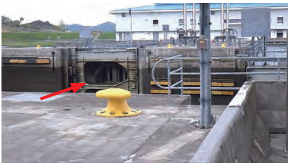
写真2(b) 引き戸式(ローリングゲート)水門
