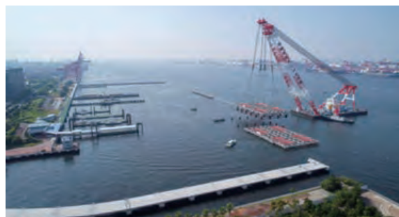
写真3 ジャケット据付状況
