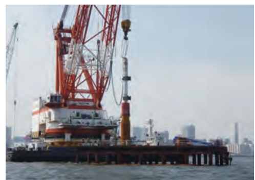
写真1 衝撃載荷試験
