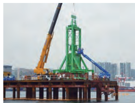
写真2 急速載荷試験
