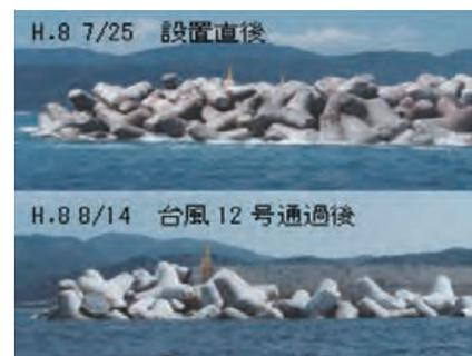
図-3 消波ブロックの変形・沈下
