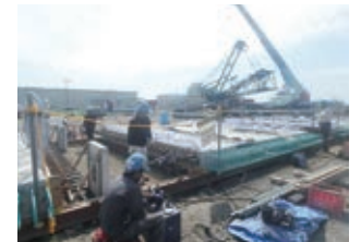
床版その他工事(棧橋ベルトコンベア基礎部に適用)
