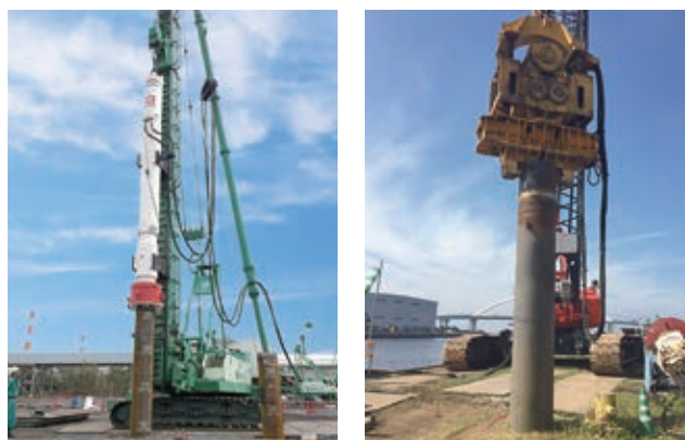
写真-4 施工試験(左:打撃工法、右:振動工法)
