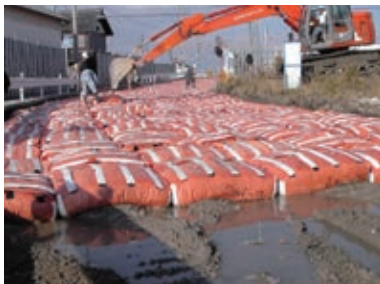
写真-1 道路の下層路盤への使用例(振動低減)
