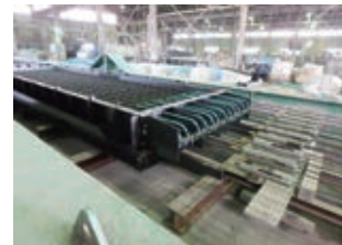
釧路西港地区(-14m)岸壁
