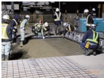
名古屋港飛島ふ頭舗装補修工事(自動搬送機使用のため)
