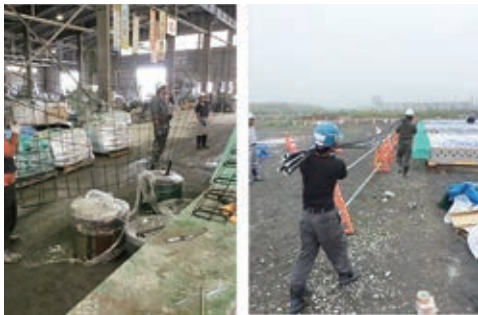
人力による作業状況
