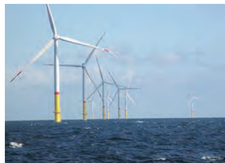
写真5 船上から望むアルコナ洋上風力発電所
