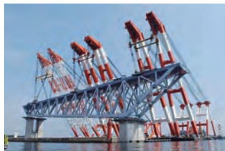
写真-1 大型起重機船3隻相吊りによる東京ゲートブリッジの架設
