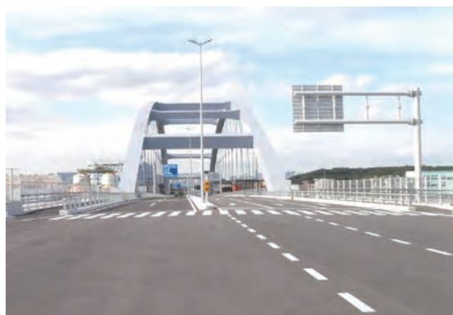
写真-9 整備状況(令和元年11月)
