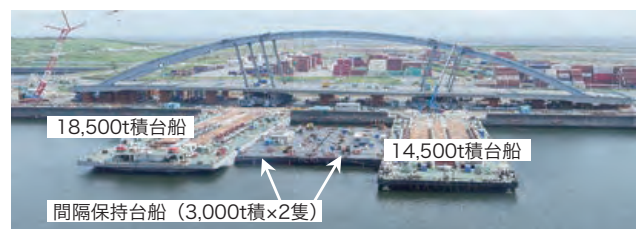
写真-6 施工ヤードにおける地組の様子
