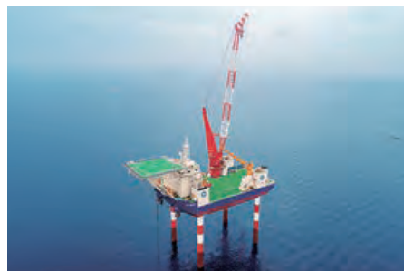
写真-2 大型クレーンを搭載したSEP船
