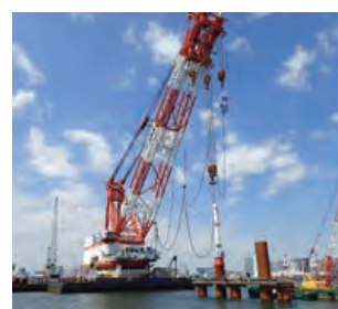
写真-1 鋼管杭打設状況
