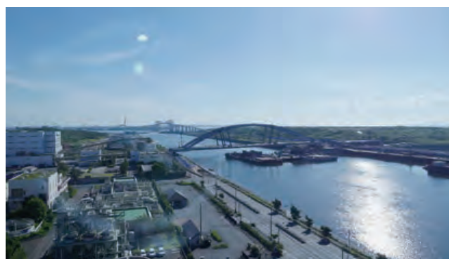
写真-8 一括架設完了
