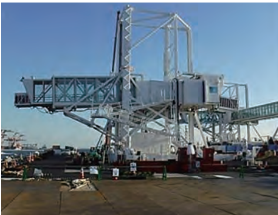
写真-4 ボーディングブリッジ据付状況(令和元年11月)
