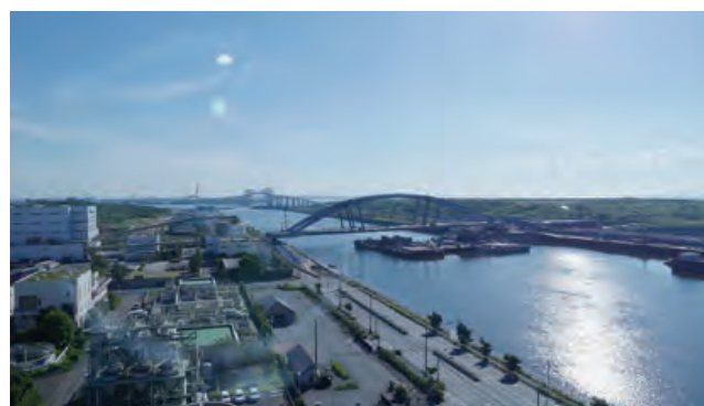
写真-8 一括架設完了
