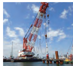
写真-1 鋼管杭打設状況
