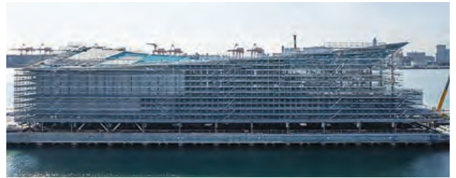
写真-5 ターミナルビル整備状況(令和元年11月)
