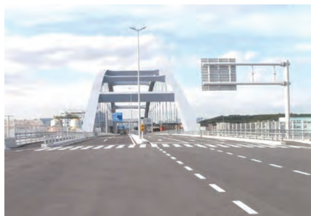
写真-9 整備状況 (令和元年11月)
