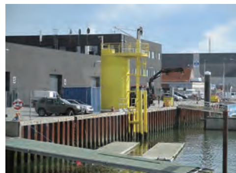
写真1 モノパイル式基礎に乗り移る訓練のための着船設備(エスビアウ港)
