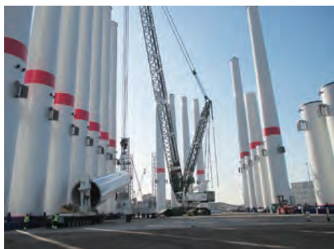
写真2 1350トン吊りクレーンによるタワーの組み立て作業(フリッシンゲン港)
