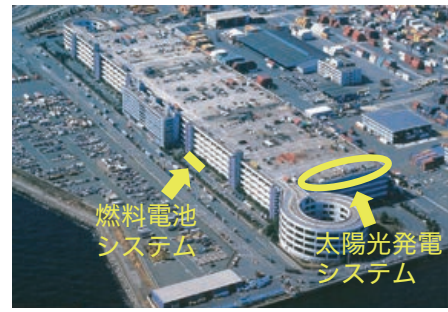
Y-CC全景及びシステム設置場所(Y-CCパンフレットを加工)
