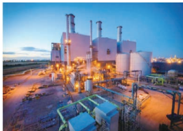
図10 イギリスのソルトエンド発電所
