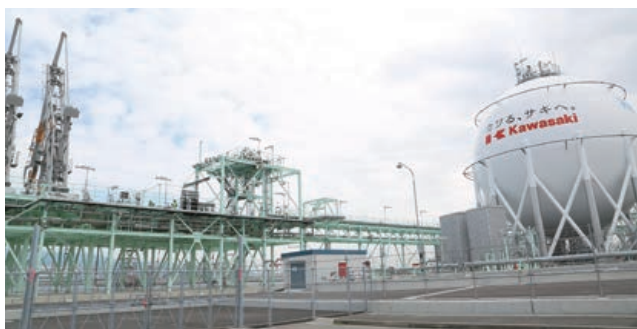
図2 建設中のターミナル外観
