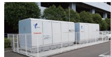
自立型水素燃料電池システム外観
