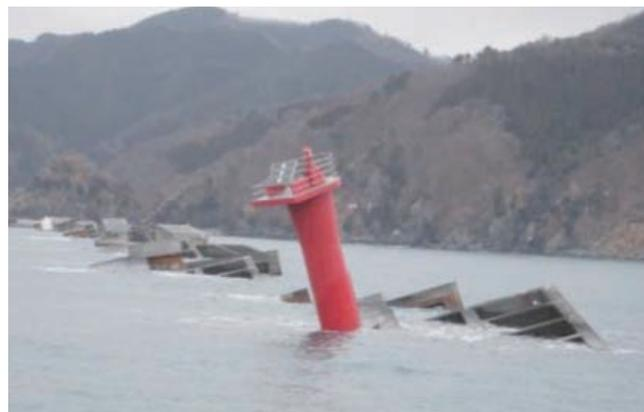
東日本大震災により被災した防波堤(釜石港湾口防波堤)
