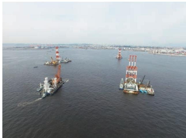
CIMを使ったサンドコンパクション(SCP)船による地盤改良工事
