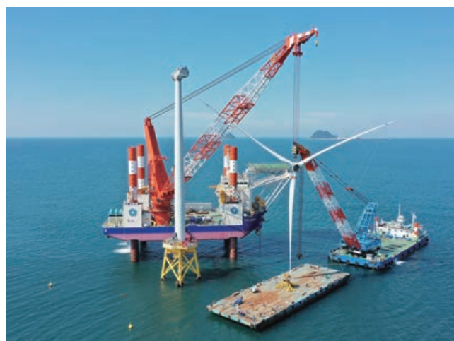
風車のブレードを撤去している自己昇降式起重機船(SEP)(北九州港響灘)
