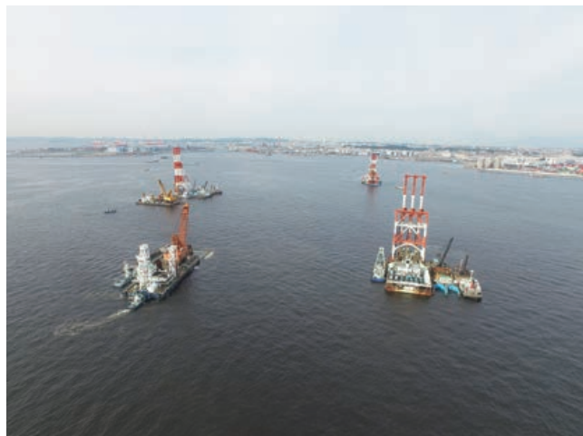
CIMを使ったサンドコンパクション(SCP)船による地盤改良工事 (横浜港新本牧)
