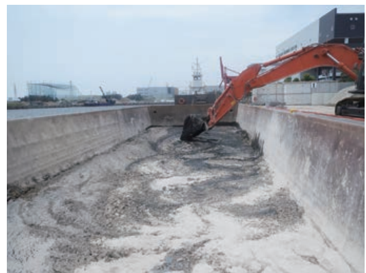
写真3 港湾浚渫土の改質事例
