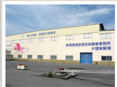
水理模型実験場の外観
