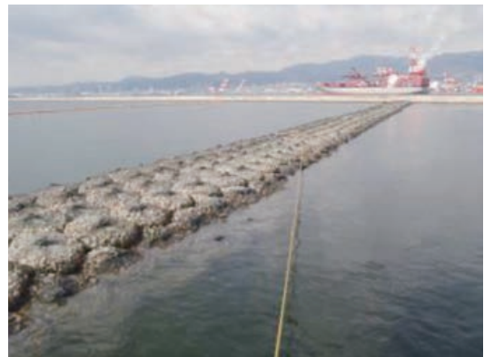
埋立護岸の施工事例
