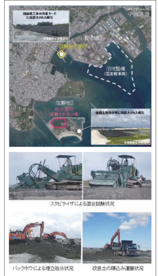
図4 軽石の埋立処分状況(中城湾)【国土交通省港湾局提供】
