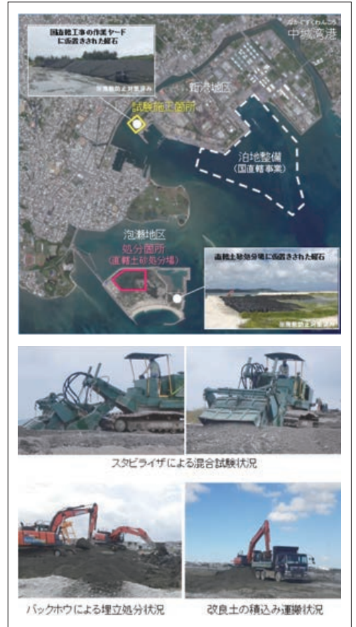
図4 軽石の埋立処分状況(中城湾港)【国土交通省港湾局提供】
