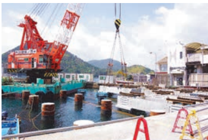
施工イメージ
