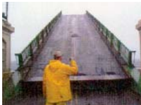
可動橋デッキへの適用例 (Clark Bridge)
