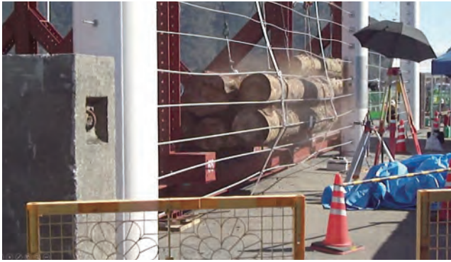
写真1 須崎港 津波バリアの衝突実験 (提供：四国地方整備局高知港湾・空港整備事務所)
