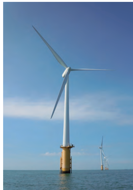
イギリスの洋上風力発電施設 （写真提供：日本港湾協会）
