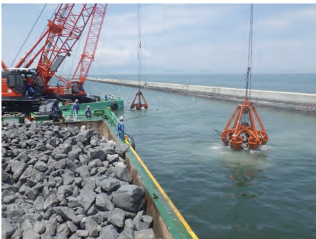
写真2 三池港 液状化対策工事(砕石投入) (提供：九州地方整備局博多港湾・空港整備事務所)
