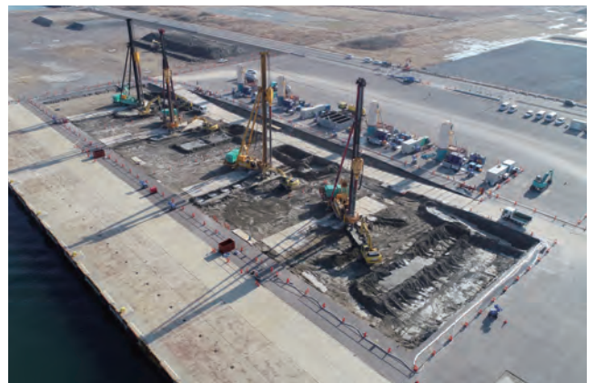
写真3 秋田港 岸壁地盤改良工事(深層混合処理) (提供：東北地方整備局秋田港湾事務所)
