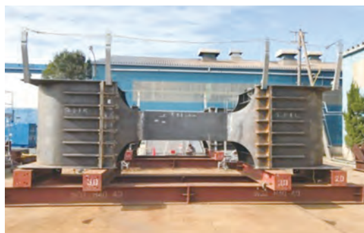
写真1 清水港日の出栈橋深梁
