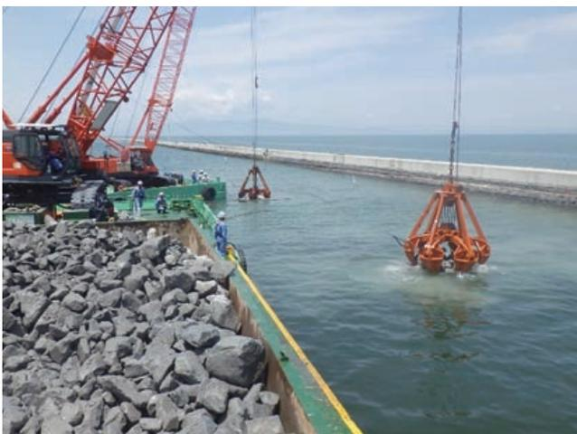
写真2 三池港 液状化対策工事(砕石投入)
