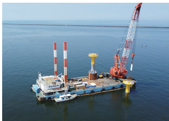
実海域大型模型実験におけるサクシヨンバケット基礎の施工
