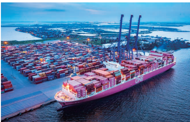
ベトナム・ラックフェン港(提供: 伊藤忠商事(株))
