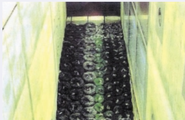
図 - 4 袋詰め被覆材設置状況（実験断面）
